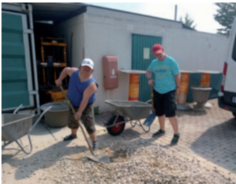
Immer am Arbeiten: Marcell und Dennis beim Schaufeln.
