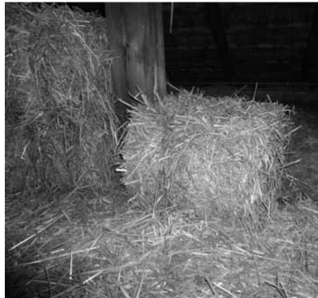
Stroh direkt vom Feld mindert den Wärmeverlust durch die oberste Geschoßdecke im Horner Pfarrhaus deutlich.
