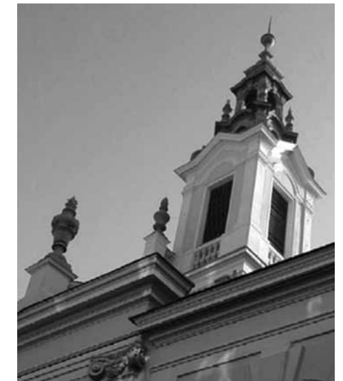
Gut versteckt produziert eine Photovoltaikanlage auf der reformierten Kirche Wien-Innere Stadt himmlischen Strom.
