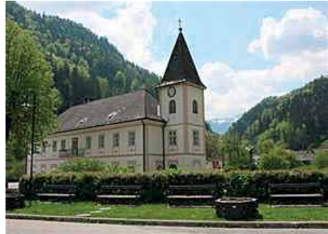
Der von Georg Hubmer gebaute Betsaal wurde später aufgestockt und mit einem Turm ergänzt. Die Kirchenfenster sind immer noch rund.
